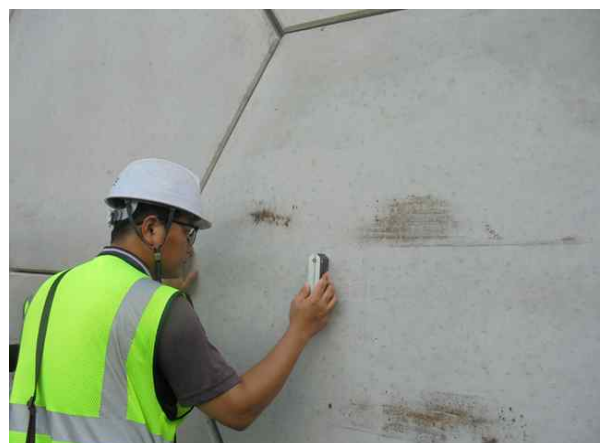
경사계를 이용한 경사도 측정
