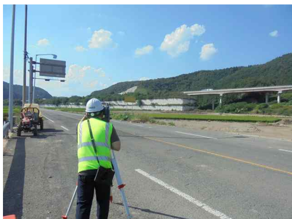
광파기를 이용한 측량 작업
